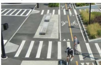
Intersection sécurisée - Piste cyclable en site propre © Queens Plaza by Margie Ruddick et al.
