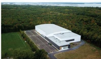
Sportplex / Complexe sportif intérieur © Ville de Châteauguay
