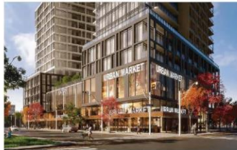
Traitement dynamique du revêtement (horizontalité vs verticalité). © Great Gulf /Hullmark
