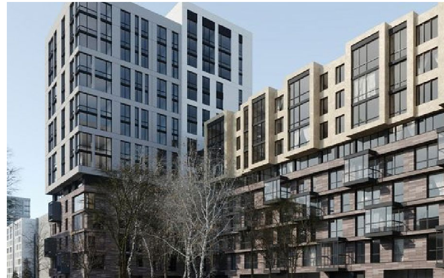
Jeu de volumes et traitement distinctif des façades. © Fayna Town – ARKHIMATIKA
