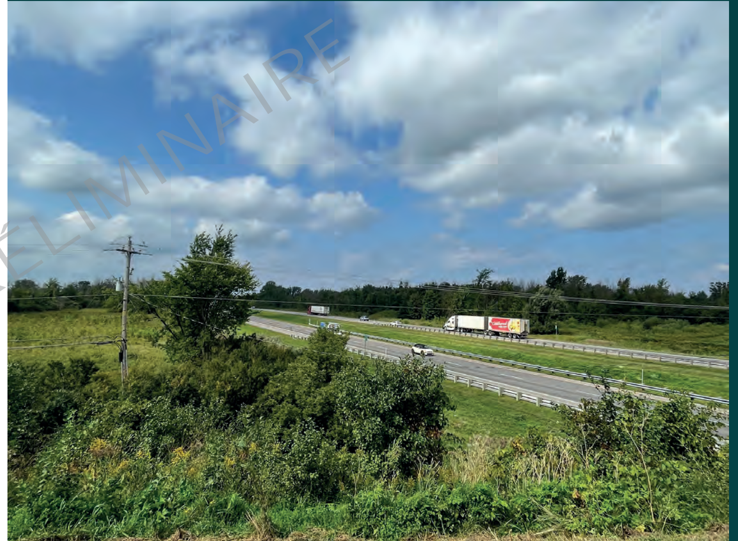
Figure 16 : Vue vers l'autoroute 30
