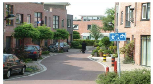
Exemple d'une rue de type «woonerf»
