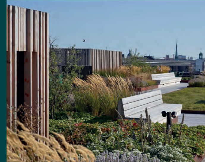
Figure 29 : Vue d'une toiture avec jardin privé, Stockholm, Suède
