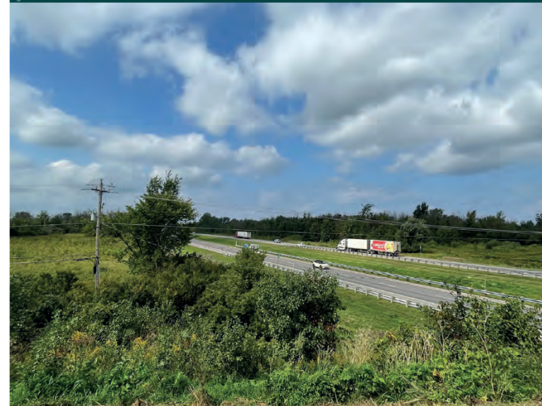
Figure 18 : Vue vers l'autoroute 30
